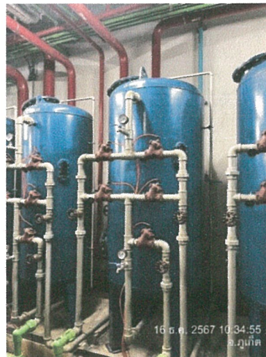
รูปภาพที่ 2.10 ถังเก็บน้ำใต้ดินและระบบกรองน้ำใช้
