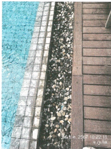
รูปภาพที่ 2.23 รางน้ำล้นรอบสระว่ายน้ำ
