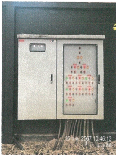
รูปภาพที่ 2.4 ตู้ควบคุมระบบบำบัดน้ำเสีย
