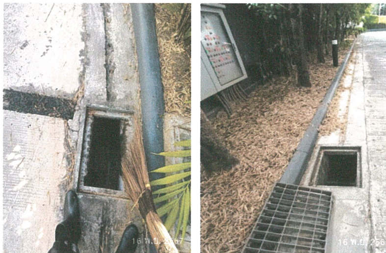
รูปภาพที่ 2.61 การขุดลอกตะกอน
